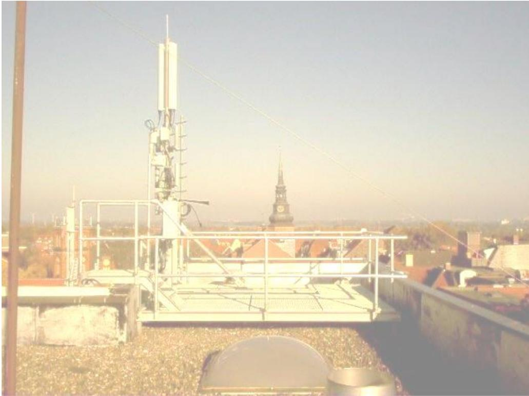
Ein neuer Dachzugang musste entwickelt werden. Das Dach besteht aus Gasbetonfertigelementen und sollte nicht betreten werden.
